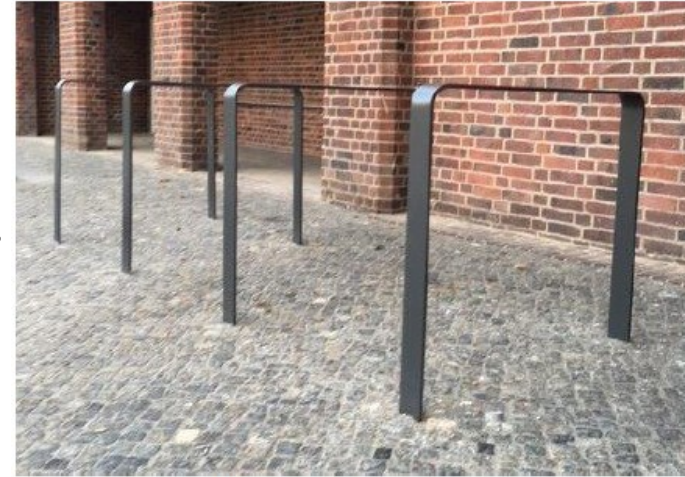
Abb. 5.21 Fahrradbügel mit denkmalschutzverträglicher Gestaltung
